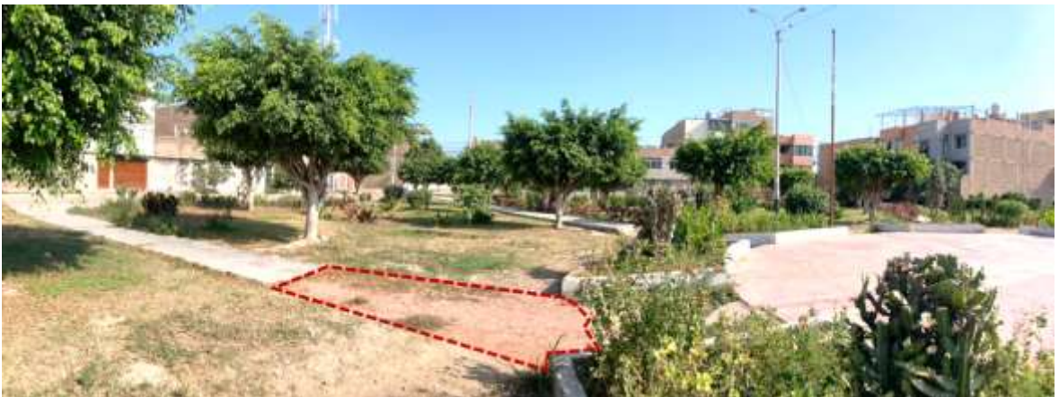
Imagen 2: Deterioro del pavimento.
