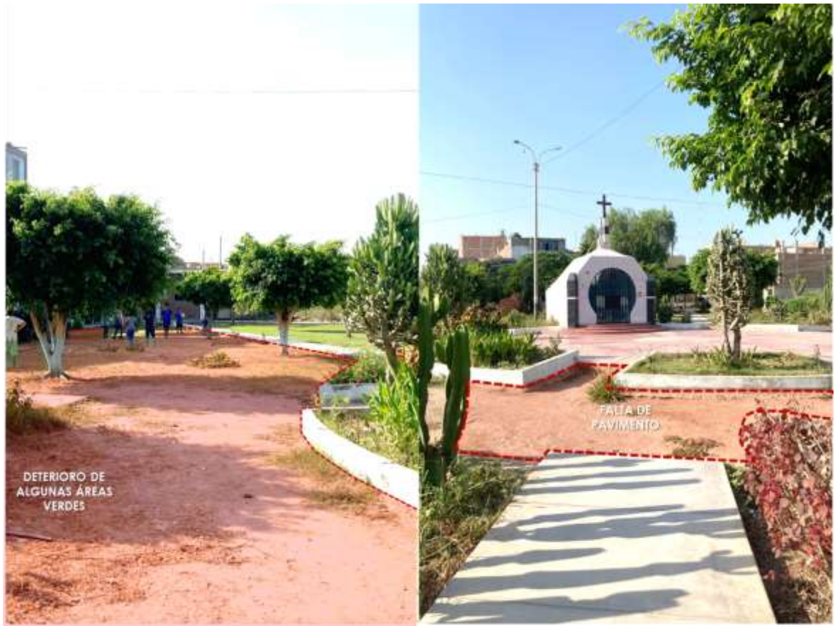
Imagen 4: Deterioro de áreas verdes y pavimentos.
