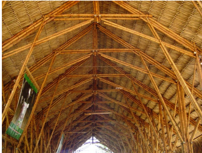
Fotografía 3. Ejemplo de estructura construida con Guadua Angustifolia. Eje Cafetero.
