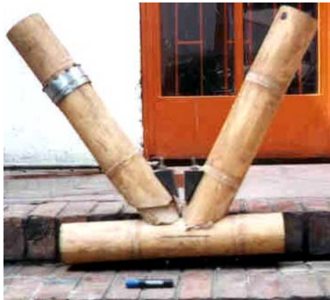
FOTO 37 FALLA UNION SVM 60°
