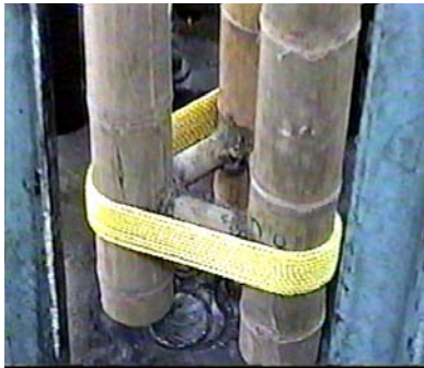
Foto No. 40. Unión tipo tres en el centro de la longitud de la columna
