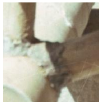
Foto No. 38. Detalle de la masilla en la unión tipo tres
