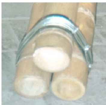
Foto No. 32. Detalle de la sección transversal unión tipo dos
