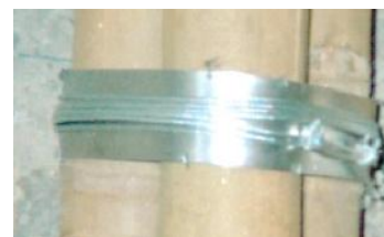
Foto No. 35. Detalle de la lámina de acero calibre 18 en la unión tipo dos
