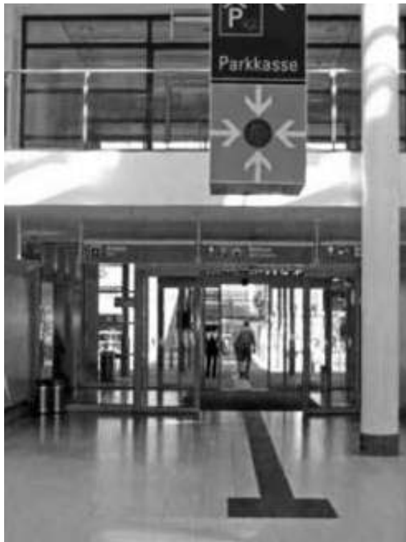
Figura 12. Aeropuerto de Bremen (ALEMANIA). Sistema de señalización visual y táctil (mediante pavimento direccional).
