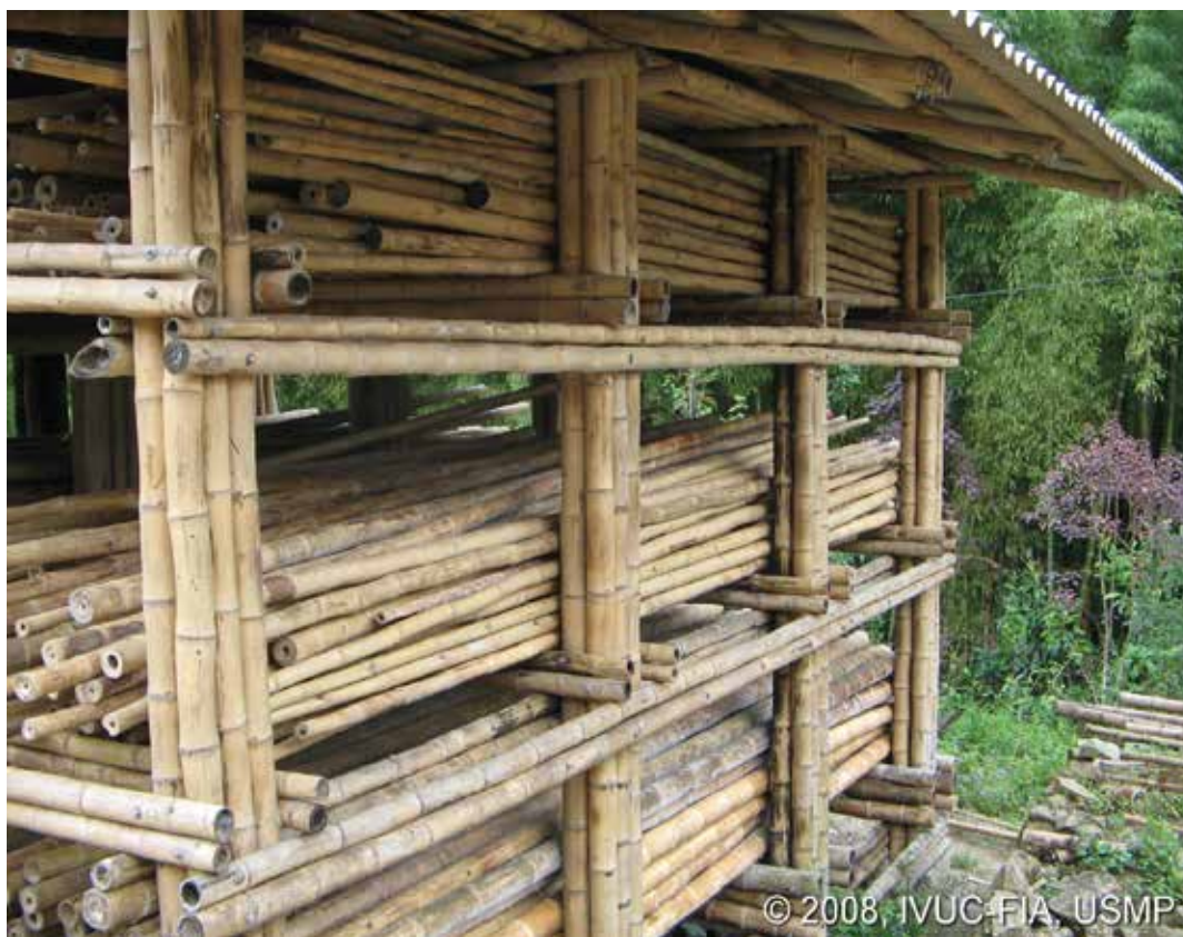
Figura 2. Almacén de bambú Guadua Angustifolia inmunizado y secado. Productores del distrito de La Florida – Lambayeque. Proyecto de la ONG CICAP
