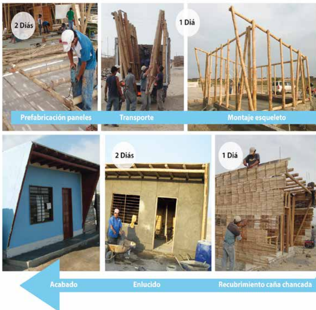
Figura 3. Proceso de construcción del Módulo de Vivienda de 22 m 2
